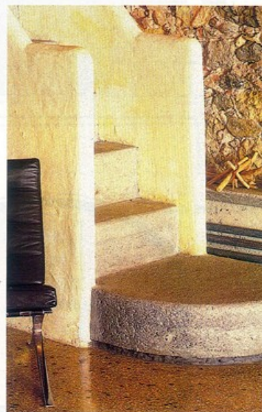
Sopra , l'ingresso con volta a botte e pavimento in graniglia a gettata unica, tipico della Liguria del Novecento; a destra , particolare della scala di accesso al primo piano, in cui il cemento armato a vista contrasta con il parapetto intonacato a calce spenta, che crea un effetto antico; nella pagina seguente , la parete in pietra sulla quale si apre una nicchia con un busto di marmo.
