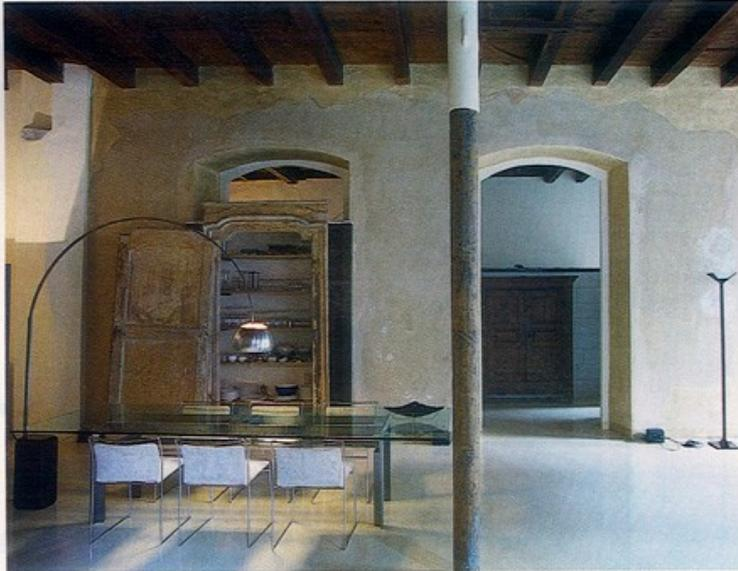
*In queste pagine, il restauro del loft, seguito dallo studio di architettura di Gianfranco Tozzini, ha mantenuto inalterata la struttura originaria, evidente nelle colonnine di ghisa e nelle travi in legno del solaio. Le scelte minimaliste dell'interior design, orientate verso l'uso di oggetti di arredo contemporanei, evidenziano le forme del mulino.*
